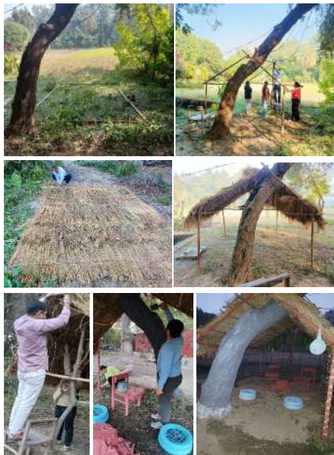
चित्र 2. विश्राम कुटी के निर्माण की चरणबद्ध प्रक्रिया (स्थान चयन से अंतिम संरचना तक)
